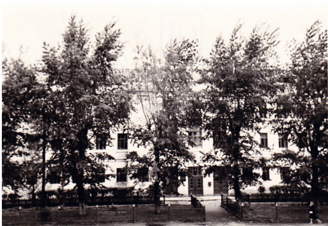
Первое здание БГМИ на ул. Ленина, 124. ГААО.
