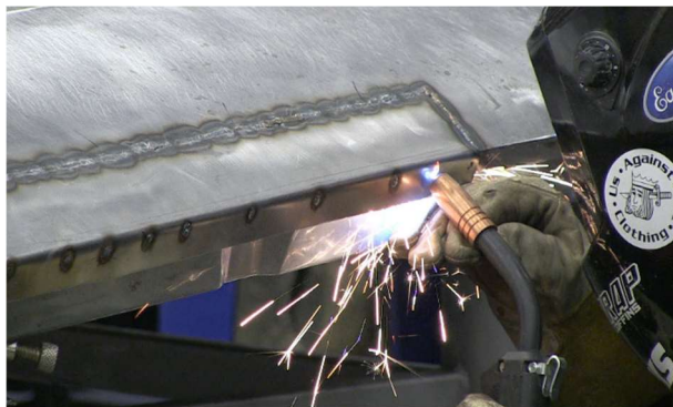
Рисунок 1 – Сварка узла агрегатов БТВТ
